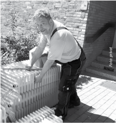
Verladen der ausgebauten Heizkörper vor dem Gemeindezentrum
