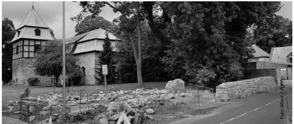
Rechts ist die im Mai 2020 fertiggestellte neue Trockensteinmauer zu sehen, links die Mauerendstücke der angefangenen Sanierung des bisherigen Mauerrests
